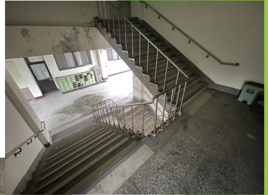
行政大樓5樓梯間 (廁所長廊側)
