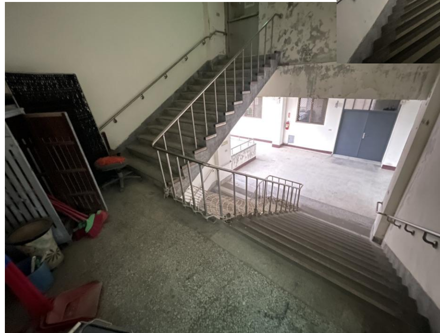
行政大樓5樓梯間 (圖書長廊側)
