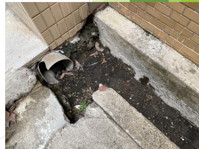
水溝淤泥清理
