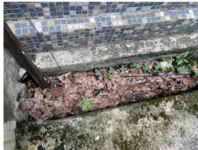
水溝落葉清理
