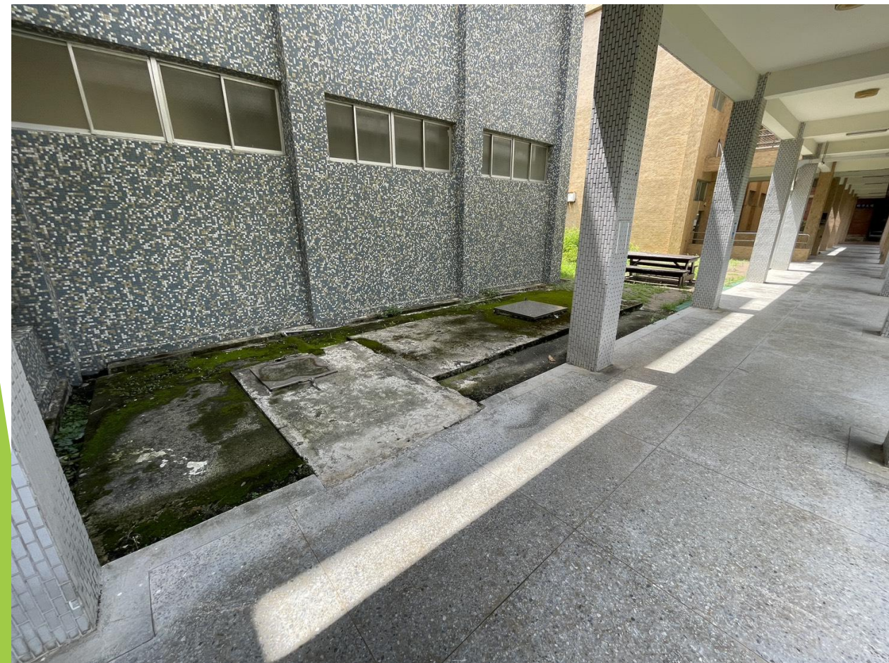
含水溝、木桌椅清理
