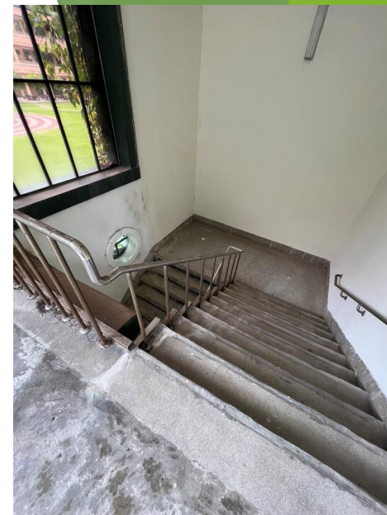
舊大樓樓梯2-1樓
